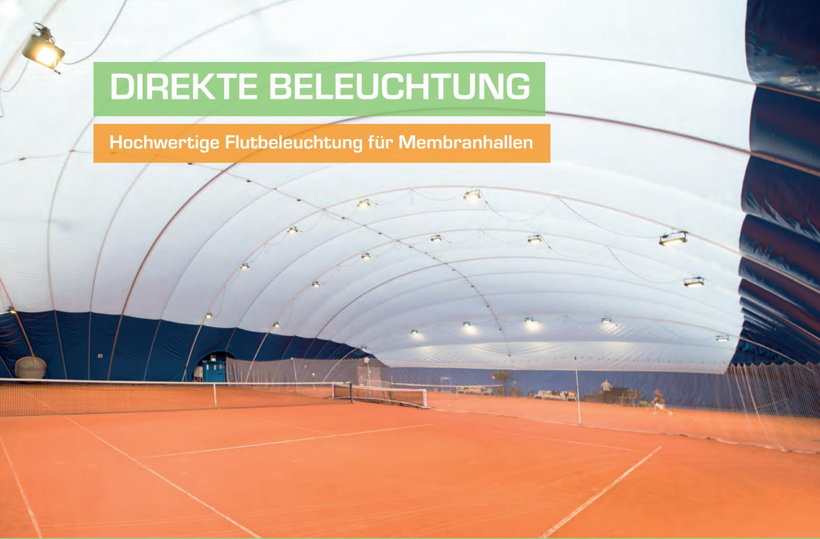
Die CLASSIC- und MASTER-Lösungen entwickelte EOLED speziell für Membranhallen. Diese beiden Lösungen bieten hochwertiges Licht, das flexibel an die örtlichen Verhältnisse der einzelnen Anlagen angepasst werden kann.
